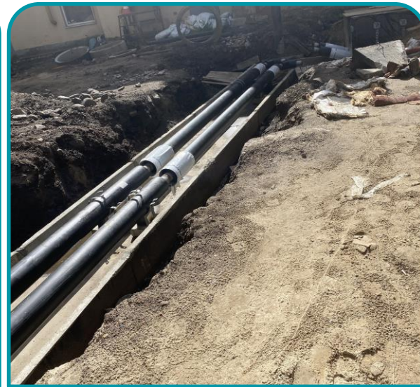
24 аварийные ситуации на системе ХВС
